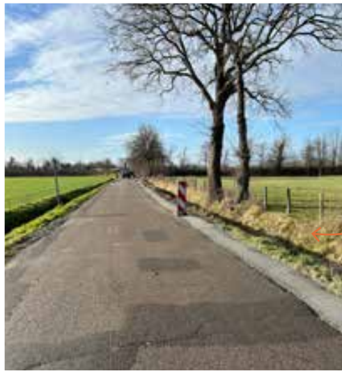
Reprise des accotements Route de Bellegarde
