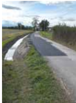
Reprise des accotements Route de Bellegarde
