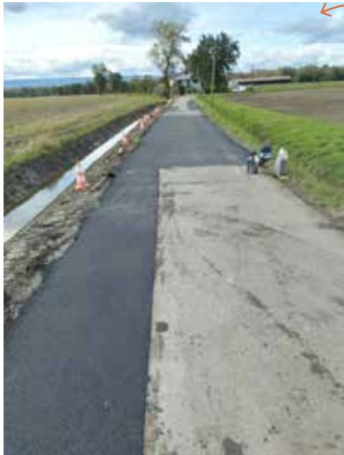
Réfection chemin de Prépieux
